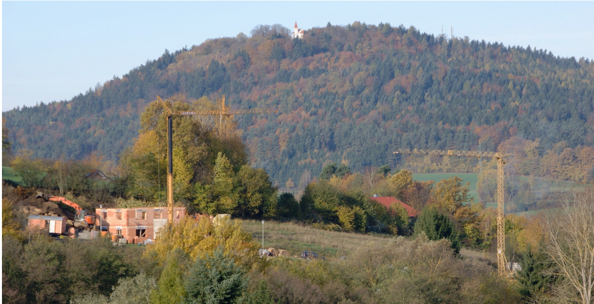
Hoch über Chamerau im Baugebiet „Sauterwiese“ entstehen die ersten Rohbauten. Mit Blick auf den Lamberg, das Baugebiet Sauterwiese. Fotos: Schropp
